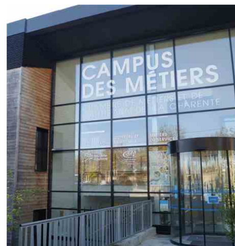
Le CFA a été remis à neuf... sauf l'atelier d'apprentissage de la tonnellerie.
